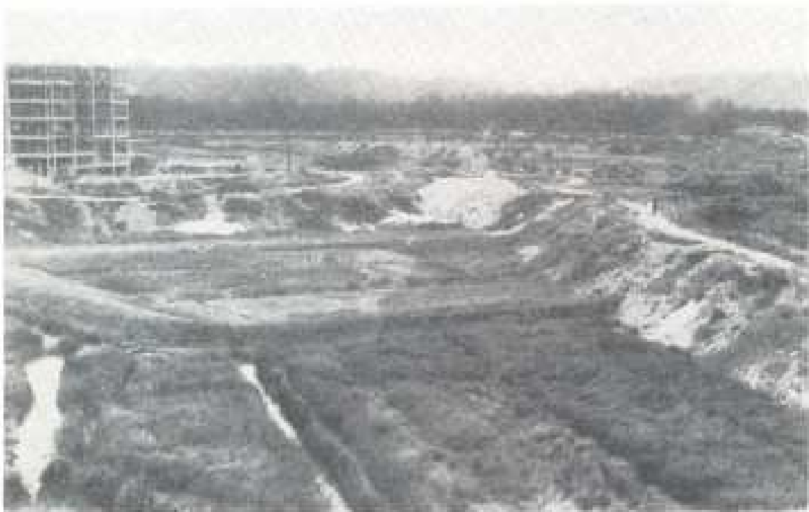
Obras de la entrada a San Sebastián
